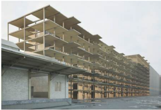
Struktur in Hybridbauweise - Betonstützen - Hybridbeam - Brettschichtholzplatte
