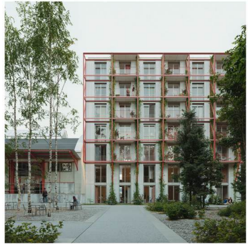
Blick vom Innenhof
